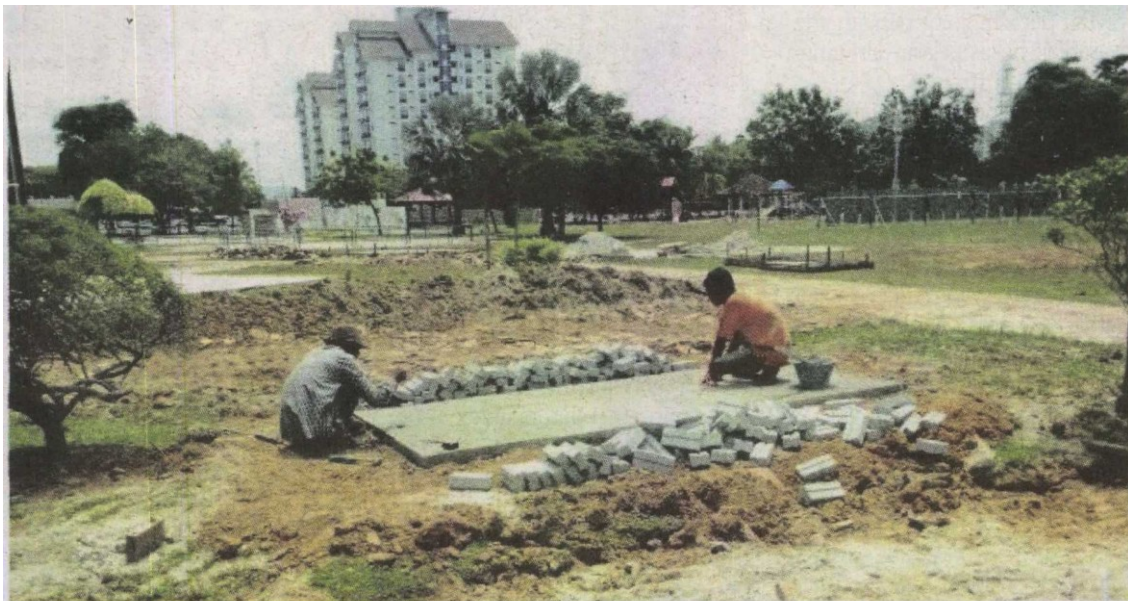
Kerja-kerja pembinaan pelbagai kemudahan fasa ketiga sedang dijalankan.
